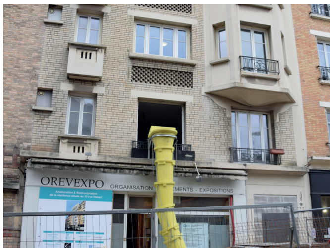
Réhabilitation du 19 rue Hébert à Clamart.
