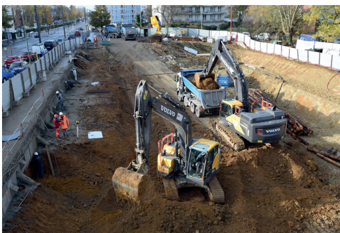
Sur le nouveau quartier Le Nôtre à Clamart, lancement de la construction des 102 logements du Domaine de La Quintinie.
