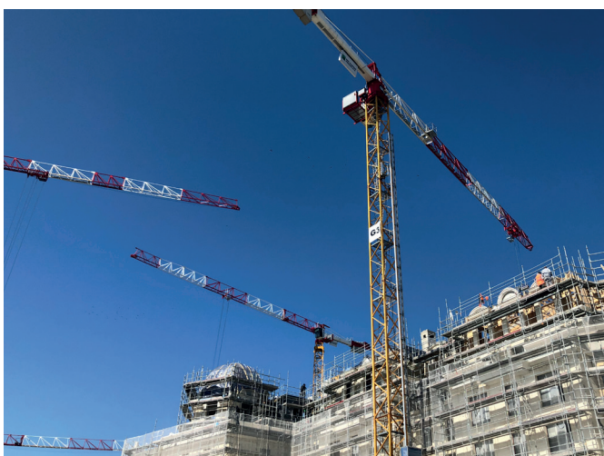
Suivi de la construction de 168 logements de la 3e tranche du Panorama à Clamart.
