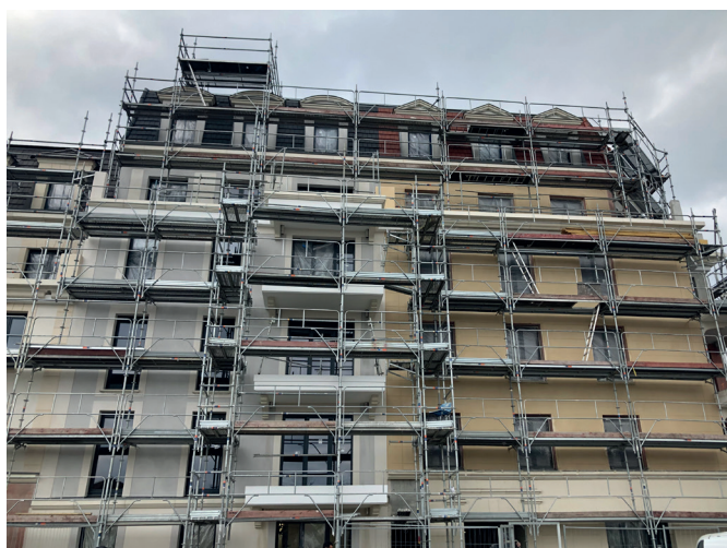
Secteur Campus à Clamart, suivi de la construction de 28 logements.
