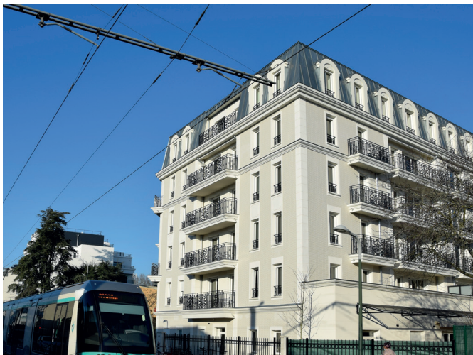
Livraison de la résidence Les Balcons de Normandie et de la crèche Amandine à Clamart.
