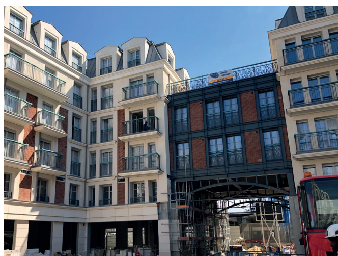
Suivi de la construction de 29 logements à la gare de Clamart.
